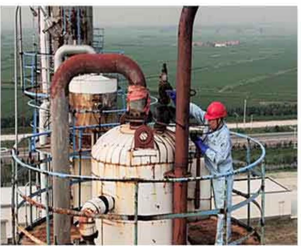
夏季是多雷雨季节，雷电对装置、设备等有很大的危害。为了做好以“防雷、防爆”为重要内容的夏季预防工作，每年雷雨季节到来之前，生产运行中心都会提前对所有设备设施、仪表等防雷接地情况进行全面细致的摸底核查，对精馏塔塔顶进行定期可燃气体检测，确保防雷接地完好和可燃气体无泄漏，发现问题及时整改，做到无一疏漏。
