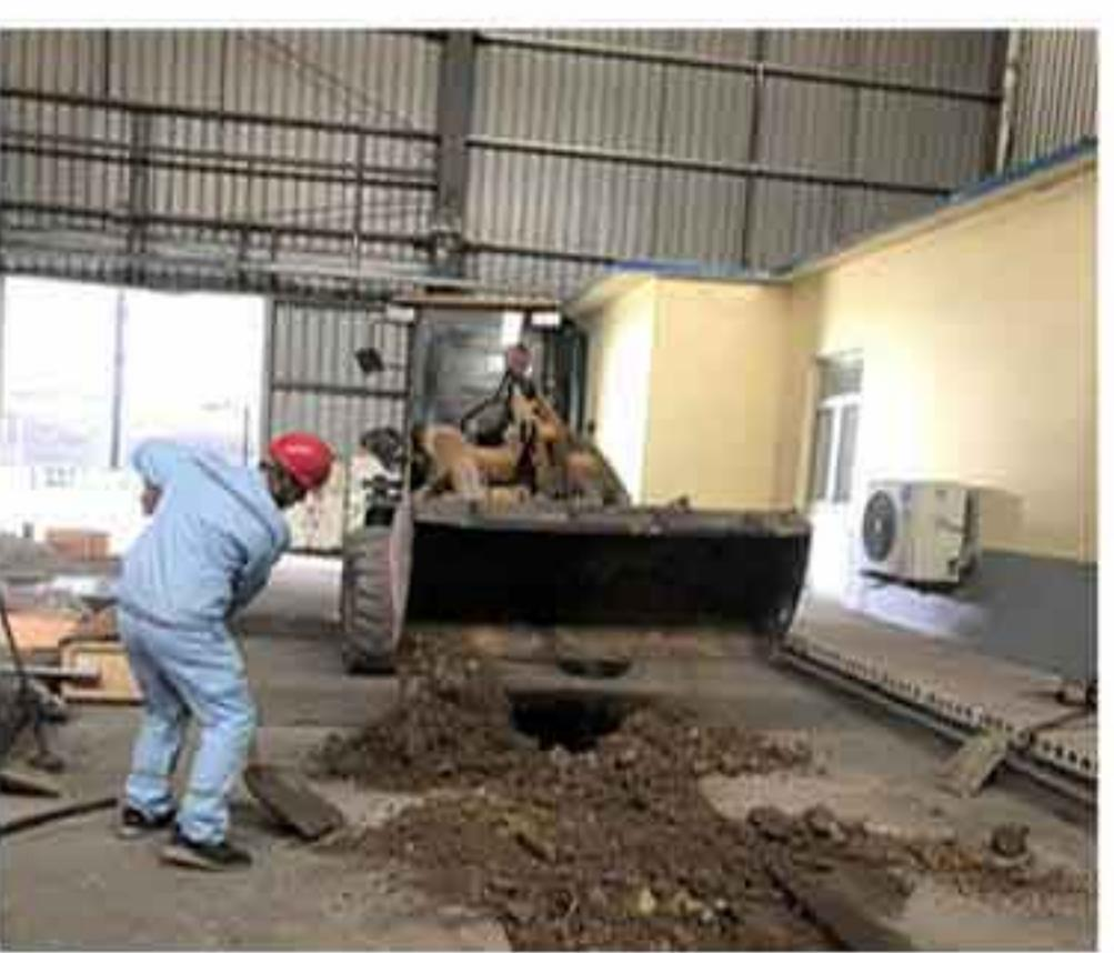
为消除原锅炉隐藏风道遗留的安全隐患，动力保障车间决定利用现有工具铁锹、铲车、大锤、电锯等对现场地面进行破除，填土压实。通过此次填土，解决路面有可能塌陷的风险，改善提高动力保障工作的环境安全。
